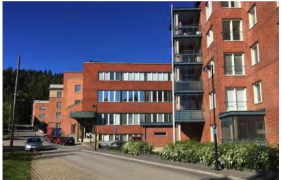
Viimeistämön julkisivun ikkuna-aukotus on rakennuksen pilari-palkkirakenteen ansiosta ollut mahdollista toteuttaa ns. nauhaikkunajulkisivuna, joka edustaa rakennusaikansa arkkitehtuurihannetta toimistorakennuksen julkisivusta. Ylempi kuva Sitowise, alempi Arkkitehtitoimisto B&M).
