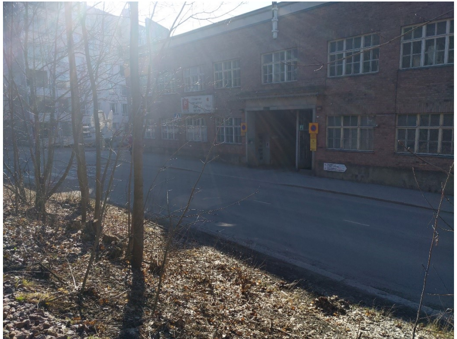
Rakennus 212 on rakentunut vuosina 1937-47. Kuva Tampereen kaupunki.
